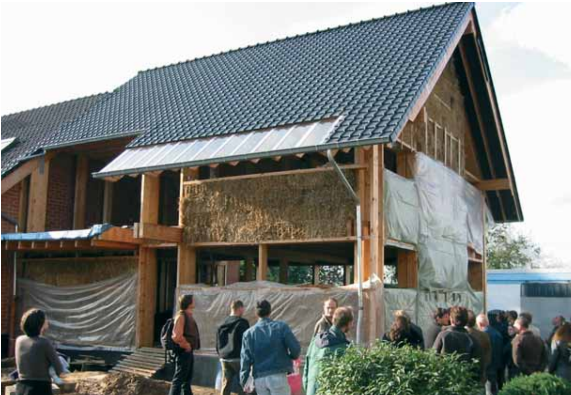
Het dak en de plasticfolie beschermen deze stobalen tijdens het bouwproces. Foto Architect Peter Vos
