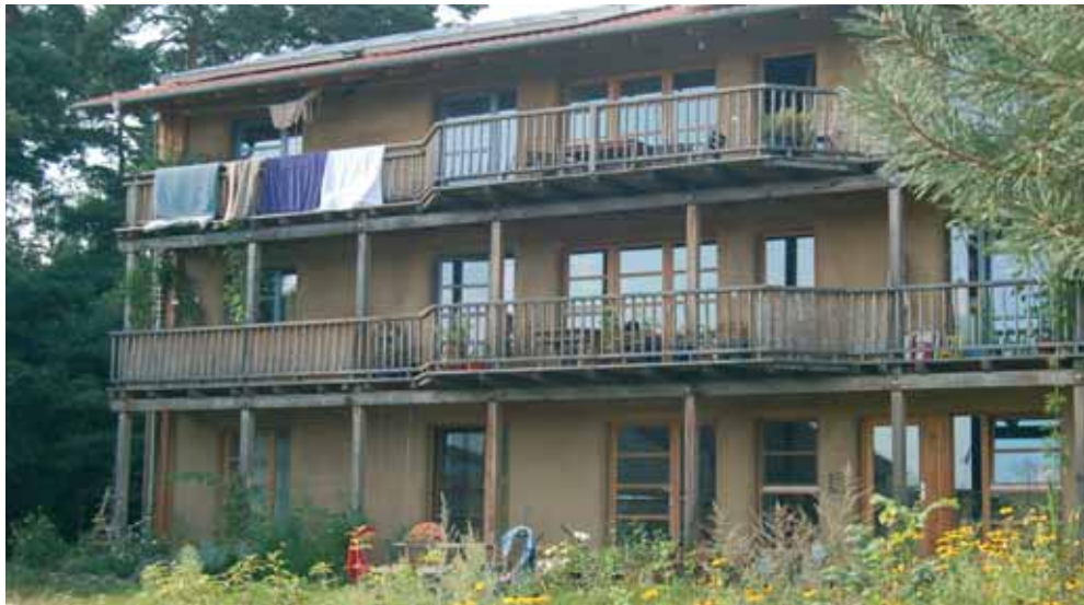
Het gebouw Strohpolis in ecodorp Sieben Linden in Duitsland. Architect Dirk Schramer. Foto Casa Calida
