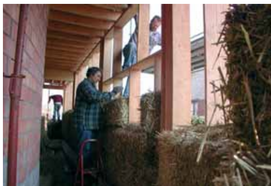
Met wat gewicht pers je de strobalen tussen het houtskelet. Foto Architect Mark Depreeuw
