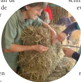
Een ijzeren priem is een handig hulpmiddel om strobalen op maat te maken.
