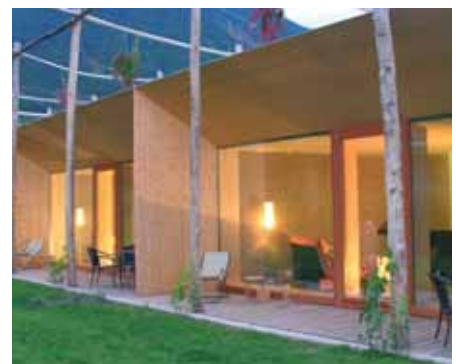
De afgewerkte vakantiewoningen. Foto Werner Schmidt
